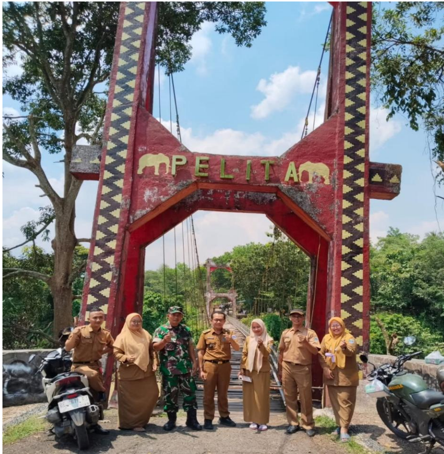
Senin, 13 April 2026, Do'a Bersama untuk Pembongkaran sekaligus Pembangunan Jembatan Gantung Pelita Penghubung Kelurahan Summersari Bantul Kota Metro dan Desa Kibang Lampung Timur.
